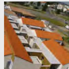
2007 : « Résidence Univers » à Cholet, 12 logements.
