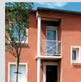
1999 : « Le Clos Saint Eloi », 17 logements.
