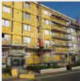
Rénovation des bardages.
