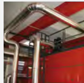
2010 : Chaufferie bois Bretagne, 1 500 personnes concernées.
