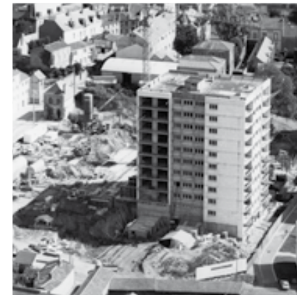
Une densification sensible du secteur : 300 logements dont 96 appartements HLM.
